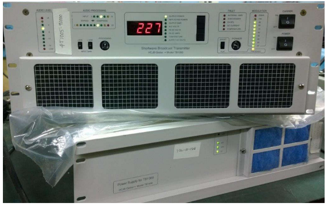
Kleiner Testlauf auf dem HCJB Gelände. Am nächsten Tag geht es auf den Pichinchaberg (4000 Höhenmeter), wo er installiert werden soll
