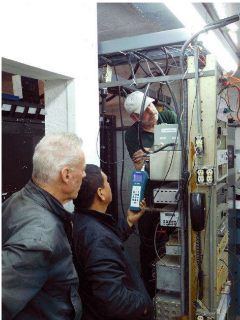
Der Sender wird in einem 19 Zoll Rack befestigt. Zum Größenvergleich: der alte Sender im Hintergrund
